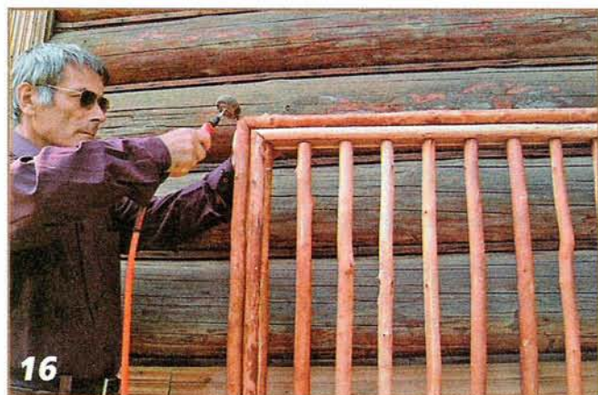
Так выглядит секция забора со сплошным заполнением жердями.
