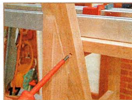
17 Крепят шуруп со стороны опоры спинки. Цековку глушат пробкой из древесины ясеня.
