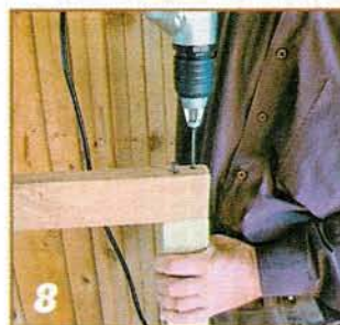
8 Соединяем брусья рам встык шурупами-саморезами.
