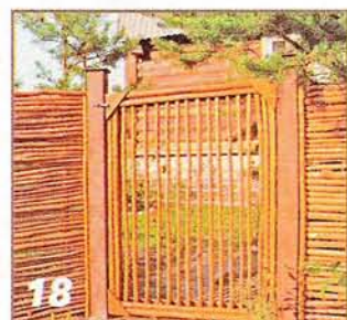
Для створок ворот по углам нужны усиливающие косынки, например — фанеры.
