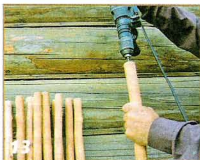
С внутренней стороны рамы сверлим направляющие отверстия крепления стержней.
