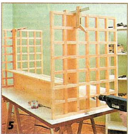
5 После крепления к подстолью боковых ножек-решёток и столешницы письменный стол готов к отделке.
