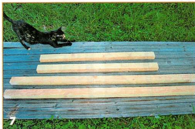
7 Для вязки рам надо заготовить брусья из сухой хвойной древесины.
