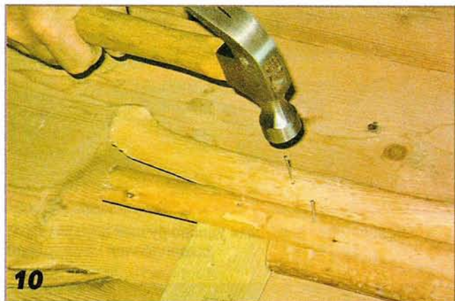
Для придания большей декоративности рамы обшиваем «половинками» жердей.
