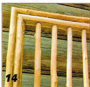
Крепим стержни длинными шурупами-саморезами с внешней стороны рамы.
