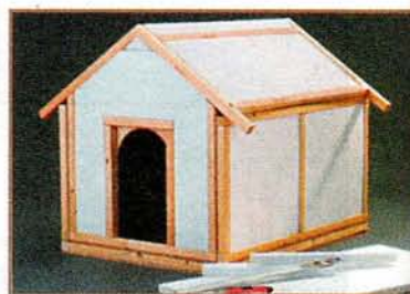
Оба элемента (пол с боковыми стенками и крышу с торцовыми стенками) вставляют друг в друга и заполняют пенопластовыми плитами.
