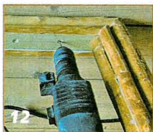
С внутренней стороны рамы сверлим направляющие отверстия крепления стержней.
