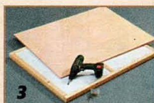
3 Основой пола служит рамка, которую обшивают фанерой с прокладкой утеплителя.
