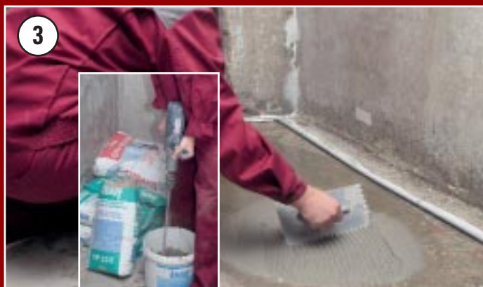
3 Для лучшей адгезии основание обрабатывают специальным составом (здесь Кнауф VP 332). Такая обработка желательна для тонкой стяжки. Когда смесь планируют укладывать слоем от 5 см, это не обязательно, однако лишним не будет
