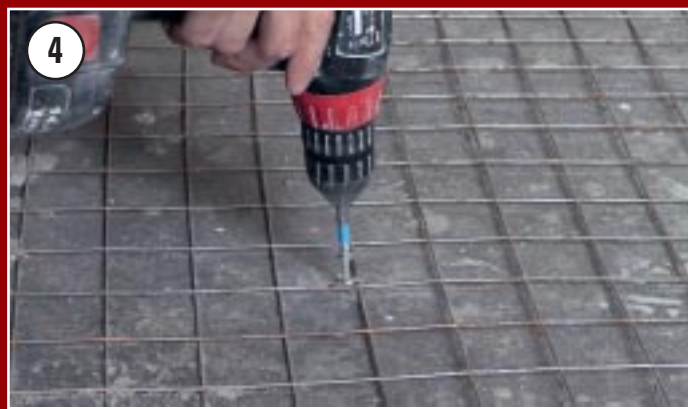
4 Если пол покрыт невпитывающим веществом (например, битумом), для стяжки в 2-3 см необходимо армирование, при большей толщине этого можно не делать. Металлическую сетку прикручивают к полу саморезами через пресс-шайбу (в нашем случае размер сетки составлял 40х40 мм)
