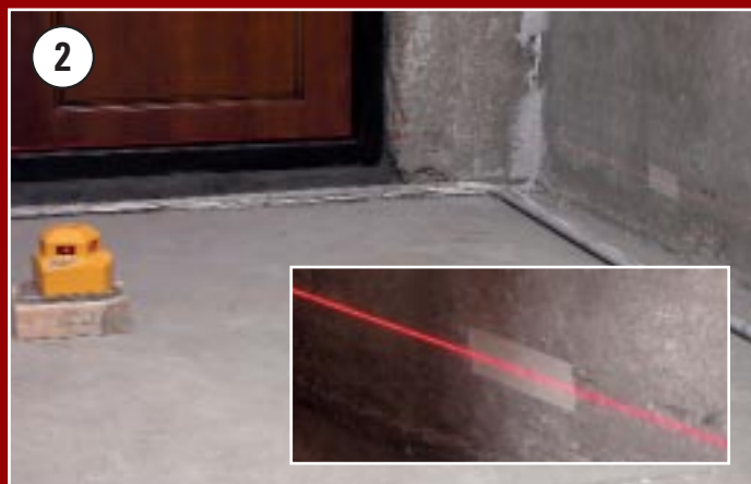
2 С помощью лазерного уровня отбивают горизонт по всей квартире и находят самую высокую точку пола
