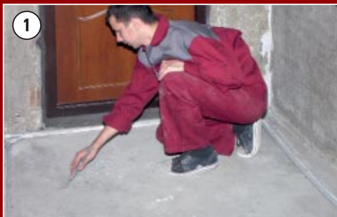
1 Первым делом готовят поверхность — убирают мусор, удаляют непрочные, отслаивающиеся участки, пылесосят
