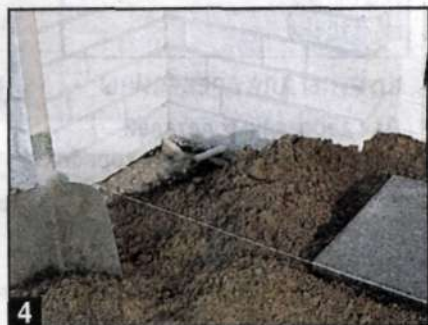
4 При укладке плит на песок или сухой раствор используют шнур-причалку.
