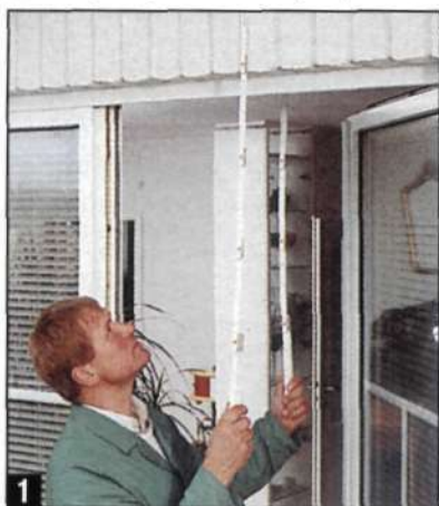
Кронштейны крепят на дюбелях к бетонному перекрытию. Для этого с помощью двух складных метров снимают внутренний и наружный размеры.
