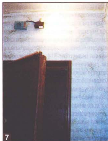
7 Дверь квартиры открывается, срабатывает датчик движения и лампа загорается.
