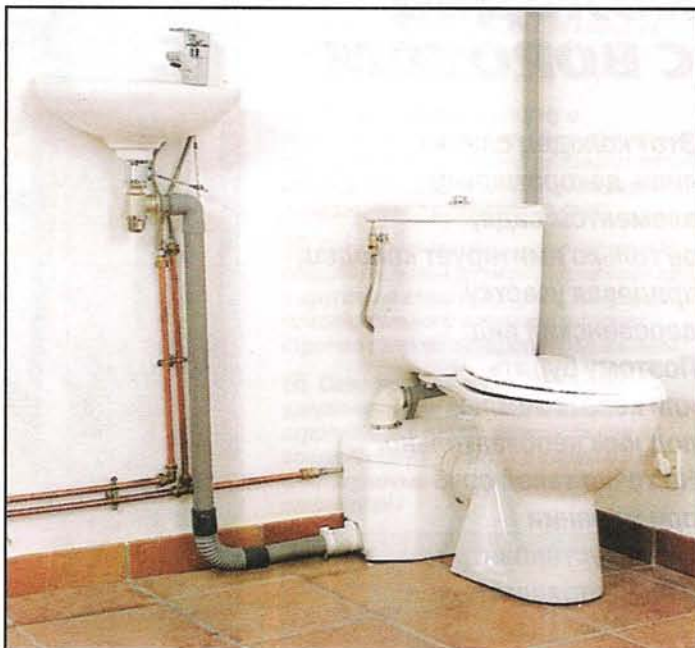
Пример размещения сантехнического насоса-измельчителя в санузле за унитазом.
