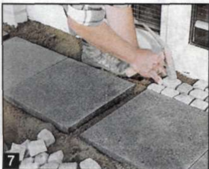
7 Все промежутки заполняют мелким булыжником из природного камня, подбивая его специальным молотком.
