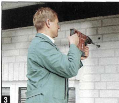
В облицовочной кладке стены с помощью перфоратора сверлят отверстие под стальную дистанционную втулку.
