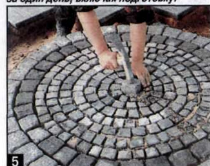
5 Венец всей работы — укладка красивого гранитного камня в центре круга. Заполнить швы можно по альтернативному варианту.
