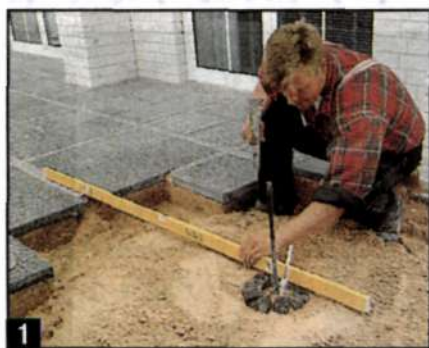
1 Первые камни кладут в середине круга, проверяя их положение уровнем. Небольшой уклон должна иметь и поверхность круга.
