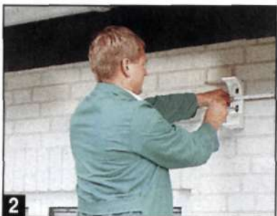
Если позволяет место, маркизу лучше установить над дверью, выходящей на террасу так, чтобы «свесы» маркизы за пределами двери были одинаковыми (здесь шириной 40 см).
