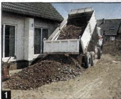
1 В отрытый котлован насыпают строительную крошку.
