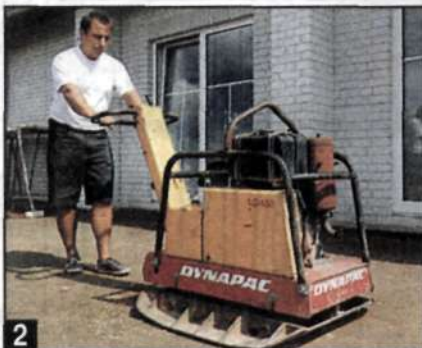
2 Отсыпанный материал трамбуют с помощью поверхностного вибратора.
