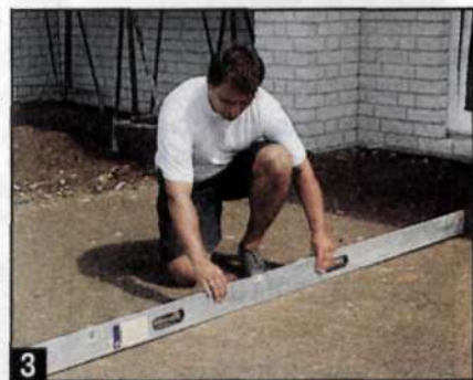
3 Основание создают с уклоном 1% (1 см на 1 м). Контроль осуществляют с помощью рейки-правила.
