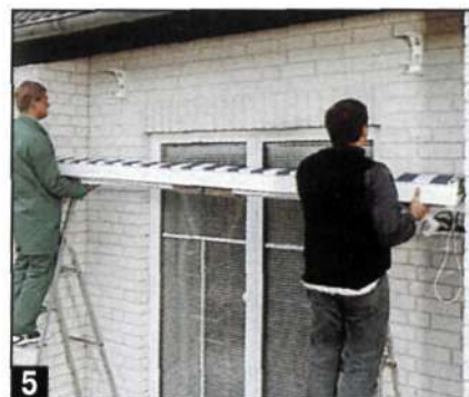
Итак, оба кронштейна закреплены. Теперь на резьбовых соединениях крепят к ним маркизу.
