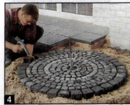
4 Постепенно, камень за камнем, круг обретает окончательную форму. Мало-мальски опытный умелец выполнит эту работу за один день, включая подготовку.
