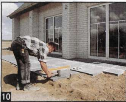
10 Уложенные плиты должны быть точно совмещены по уровню. Там, где необходимо, их подбивают резиновым молотком или молотком плиточника.
