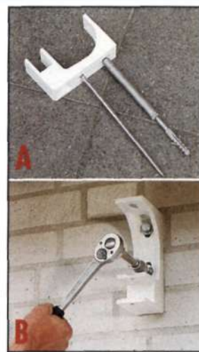
Маркизу подвешивают на кронштейнах, прикрепляемых к стене на дюбелях.
