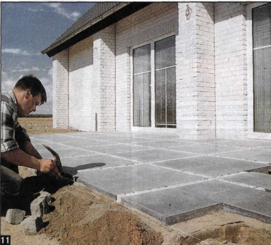
11 Пол террасы обрамляют бордюром из более крупного булыжника, создавая за ним надежную «подпорную стенку».
