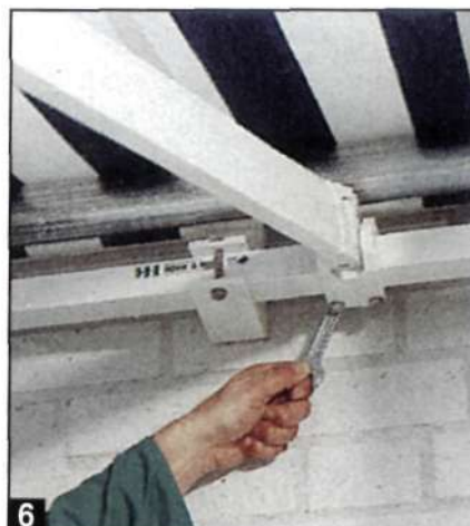
Маркизу выверяют с помощью уровня. На какой высоте ее установить, решают сами. Регулировку установки маркизы производят гаечным ключом. Положение маркизы можно регулировать в пределах 45°.
