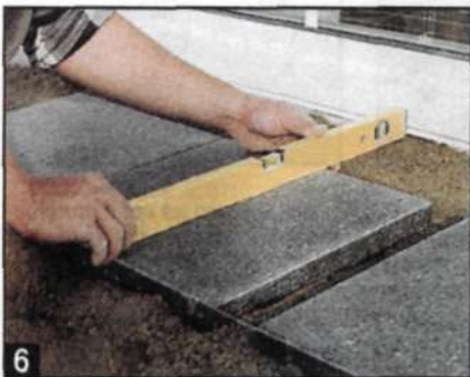
5 При укладке следующего ряда плит положение шнура меняют. Между шлифованными плитами размерами 40х40 см кладут гранитный булыжник размерами 4х6 см.
