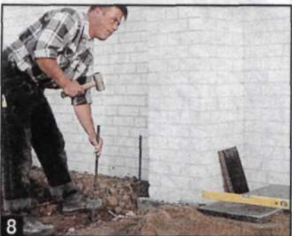
8 При укладке плит следует уделить внимание взаимному совмещению их рядов.
