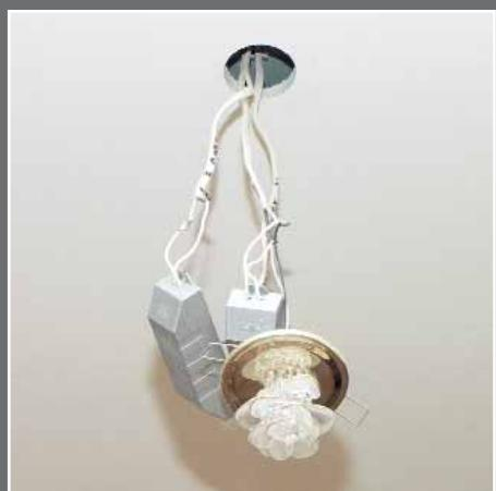
Кадр из серии «нарочно не придумаешь». В принципе все это будет работать. Только кому же пришло в голову для светильника с миниатюрным установочным диаметром приобрести гробы-трансформаторы, которые невозможно пропихнуть в отверстие в подвесном потолке? Да и как их обслуживать потом, если доступ ограничен? Опять же, чем объясняется необходимость монтировать два трансформатора в одно отверстие?
