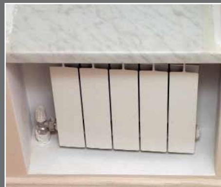
Пример неправильной установки радиатора водяного отопления. То, что его лицевая поверхность не параллельна плоскости стены, не только режет глаз, но и искашает конвективные потоки. К тому же не выдержаны установочные размеры (зазоры между прибором, полом и подоконником), что затрудняет уборку и техобслуживание
