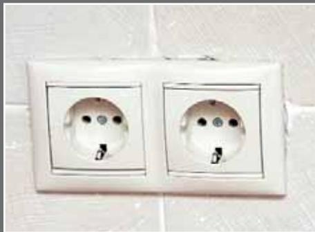
Неплотное примыкание корпуса розетки к плоскости стены чревато быстрым выходом ее из строя
