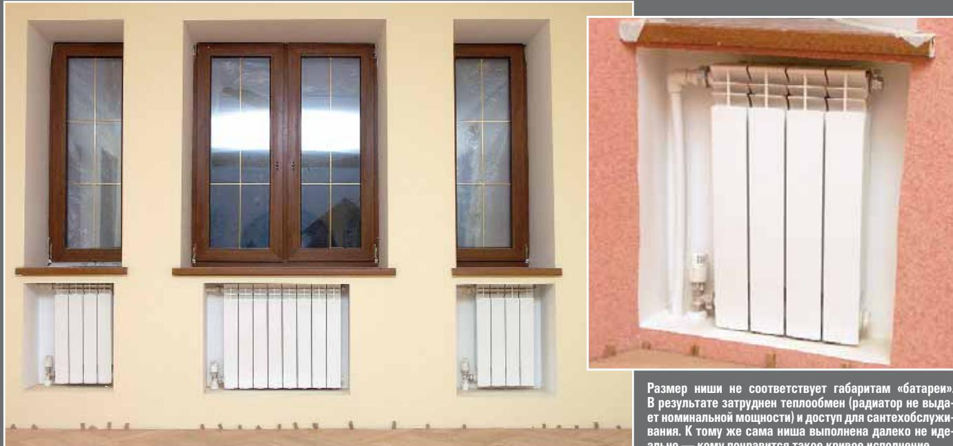
Размер ниши не соответствует габаритам «батареи». В результате затруднен теплообмен (радиатор не выдает номинальной мощности) и доступ для сантехнического обслуживания. К тому же сама ниша выполнена далеко не идеально — кому понравится такое кривое исполнение
