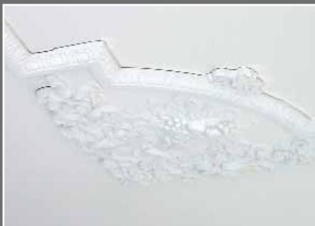
Неправильный монтаж пластиковой «лепниной» на потолке. В результате – щели, трещины, общая неопрятность...
