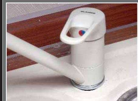
Щели под корпусом смесителя не только не эстетичны, но и грозят протечками. Планшайбу следует центриро-вать или использовать другой установочный комплект с размером, соответствующим отверстию в мойке
